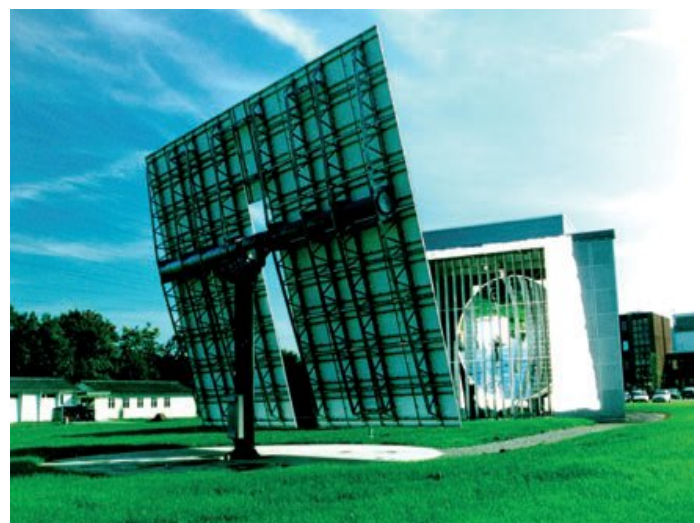
Der Solarofen am PSI. Konzentrierte Solarstrahlung dient als Energiequelle mit über 5 MW/m 2 .
